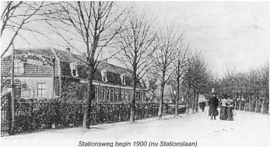
Stationsweg begin 1900 (nu Stationslaan)
