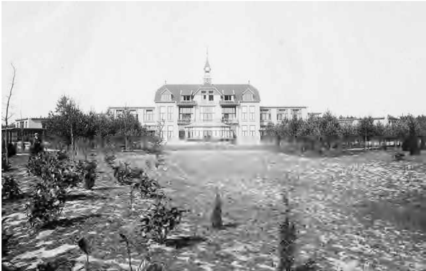
Bij Sonnevanck wordt in 1909 een start gemaakt met de bouw van het hoofdgebouw dat al in 1910 kan worden opgeleverd
