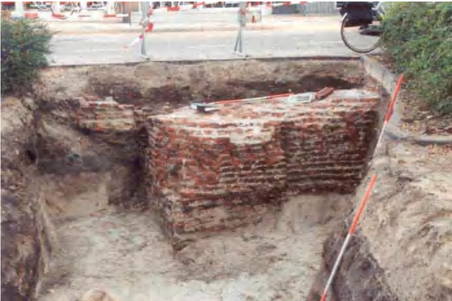
Muurwerk in werkput 5
