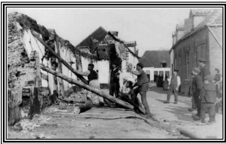
Omverhalen Doelenmuur om plaats te maken voor nieuwe arbeiderswoningen
