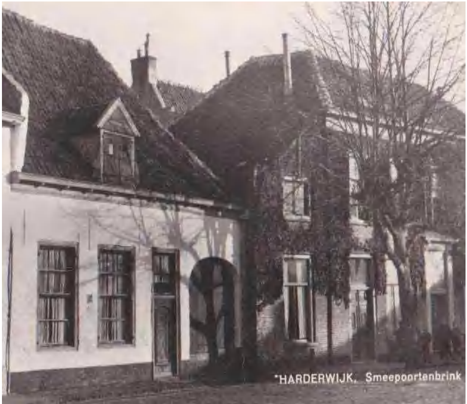
De Paradijspoort voor de restauratie
